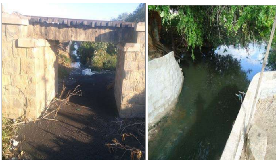
Figura 30 – (a) e (b) Imagens fotográficas de lançamento in natura de esgoto
