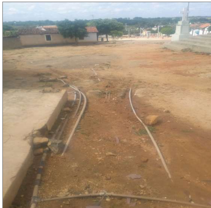
Figura 2 – Rede de distribuição de água no Sítio Várzea Comprida dos Leites.
