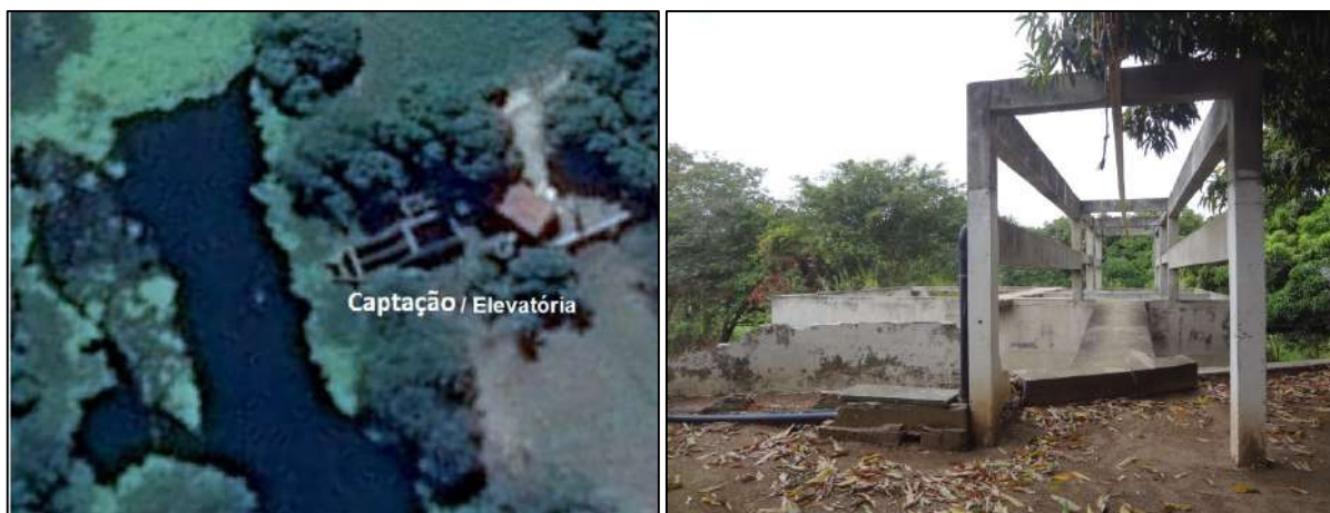
Figura 5 - Imagem de satélite (a) e fotografia (b) da captação e estação elevatória do SAA de Pombal - PB.
