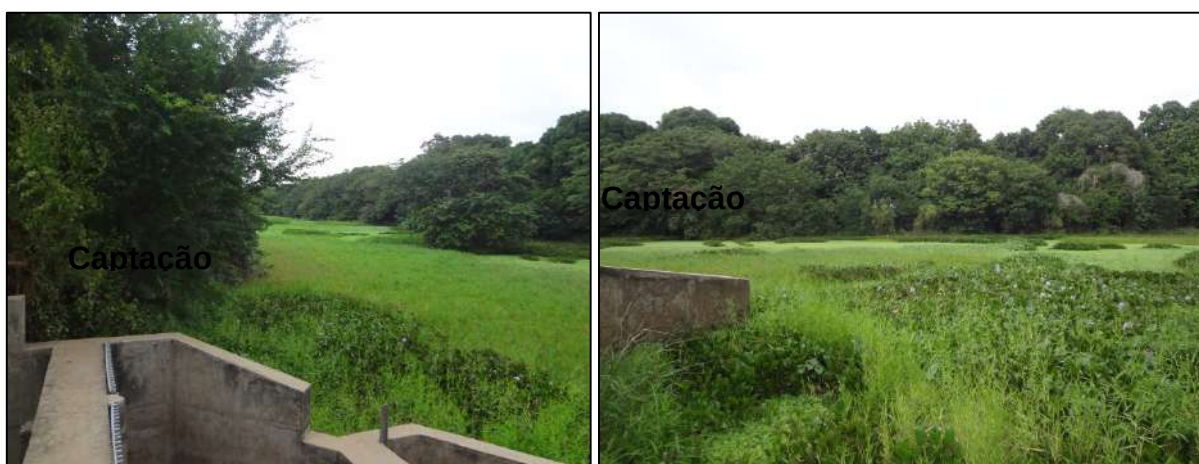
Figura 7 - Processo acelerado de eutrofização no local de captação de água do SAA de Pombal - PB.
