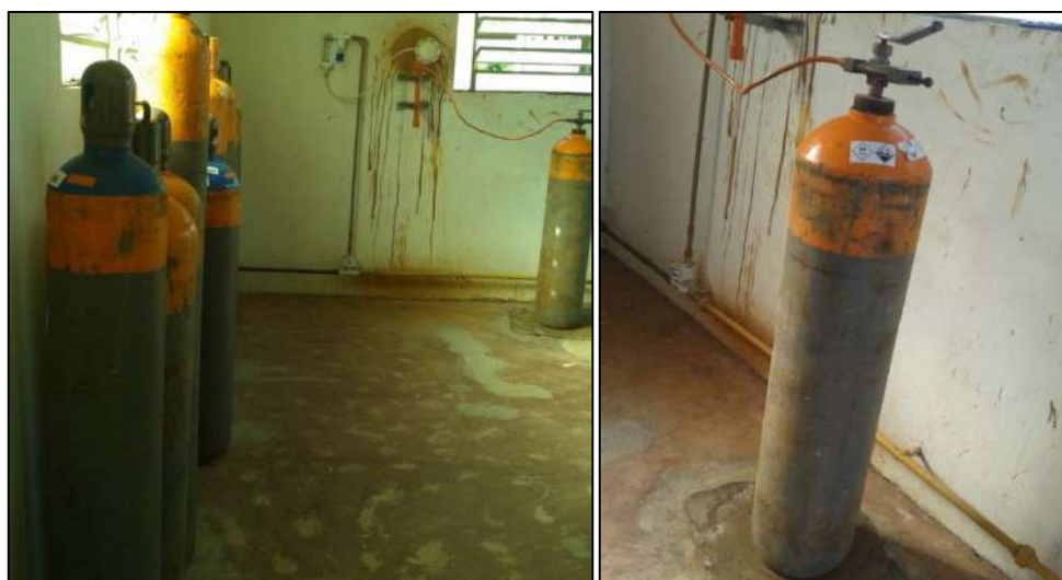
Figura 21 - Etapa de desinfecção da água na ETA de Pombal – PB.
