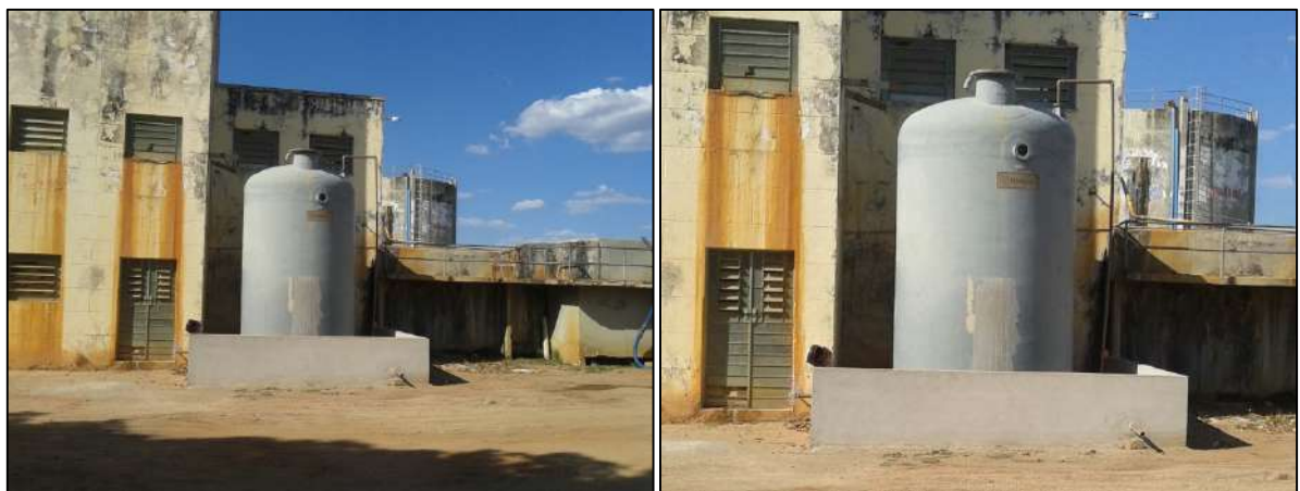
Figura 15 - Reservatório de armazenamento do sulfato de alumínio líquido da ETA de Pombal – PB.
