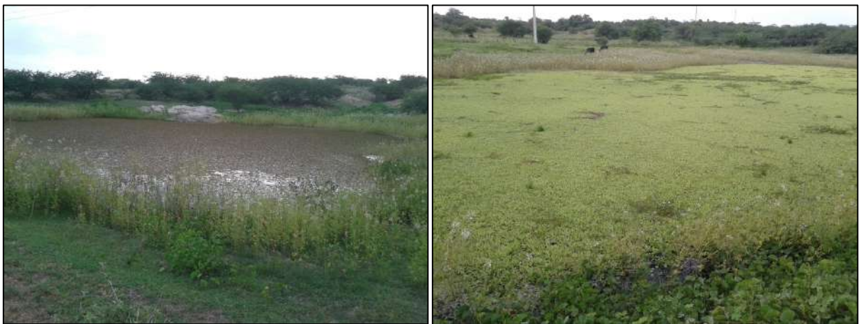
Figura 18 - Lagos artificiais onde são lançados os resíduos da limpeza dos decantadores da ETA de Pombal – PB.
