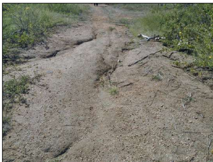
Figura 6 - Focos de erosão acelerada em Pombal-PB.
